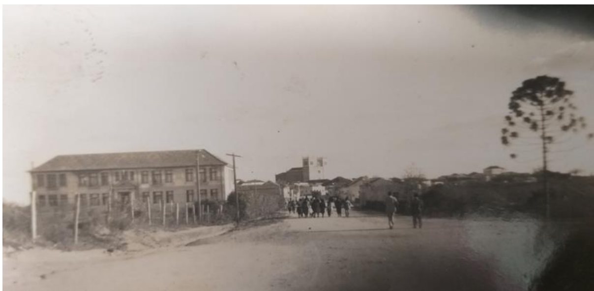
Figura 13: Prédio próprio da escola, em construção - 1936
