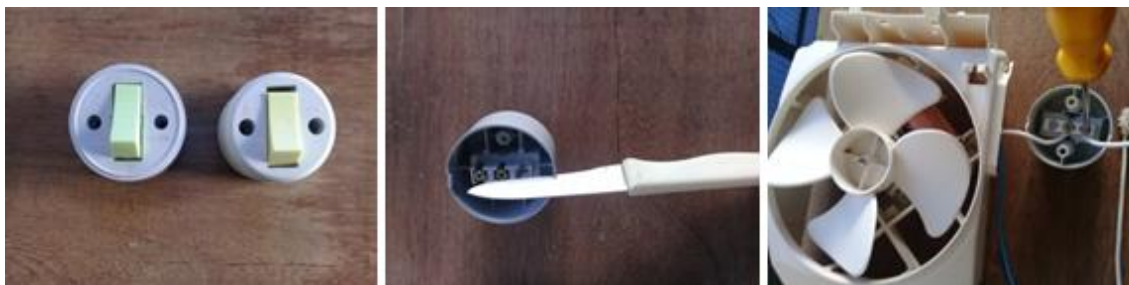
Figura 37: Preparação do interruptor e conexão dos cabos do ventilador
