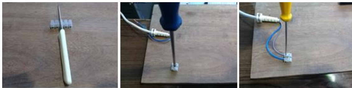
Figura 35: Fixação dos terminais e conexão do cabo de alimentação
